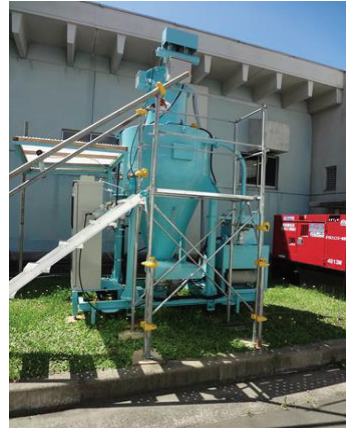
仮設の粉末活性炭注入設備
