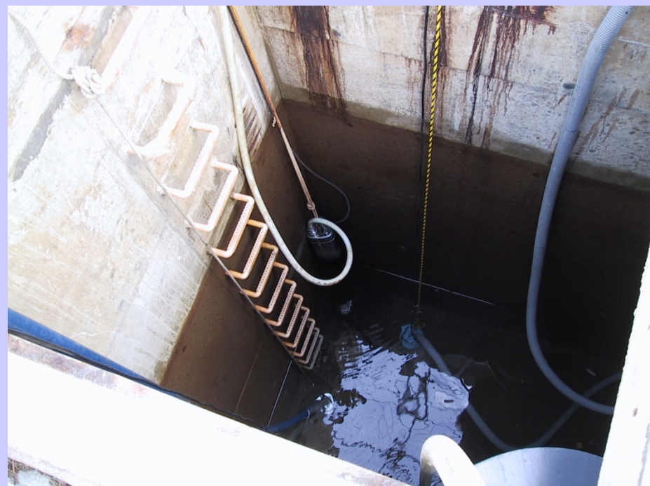
フロート弁室
